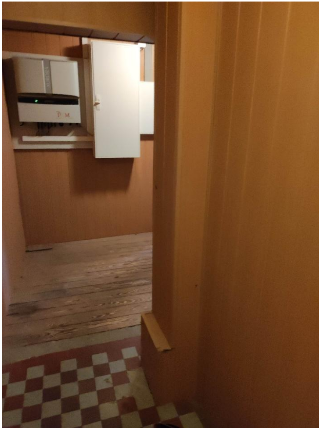
Rückbau Wandpaneele, Holzdielung, Fliesen und Estrich
