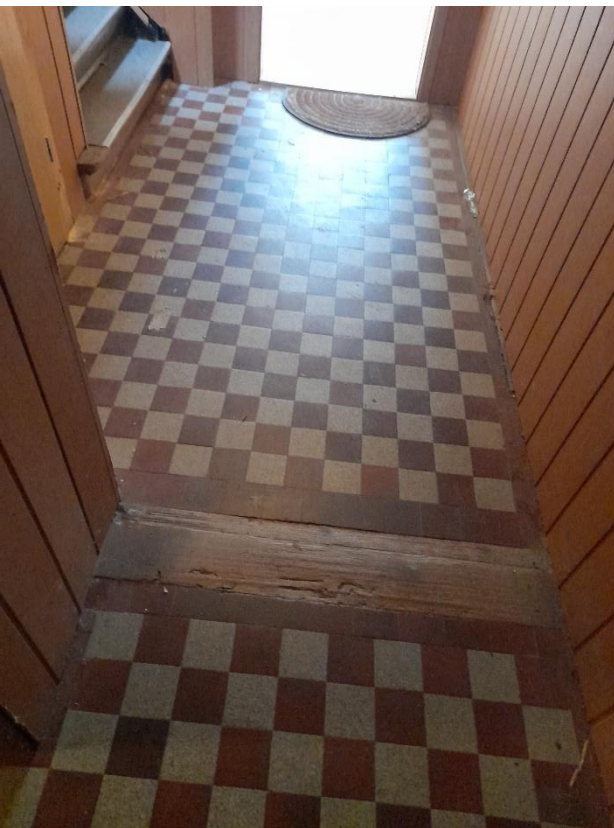
Rückbau Fliesen und Estrich
