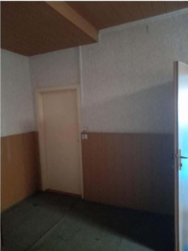
Rückbau Innentüren, Holzpaneele, Teppichboden
